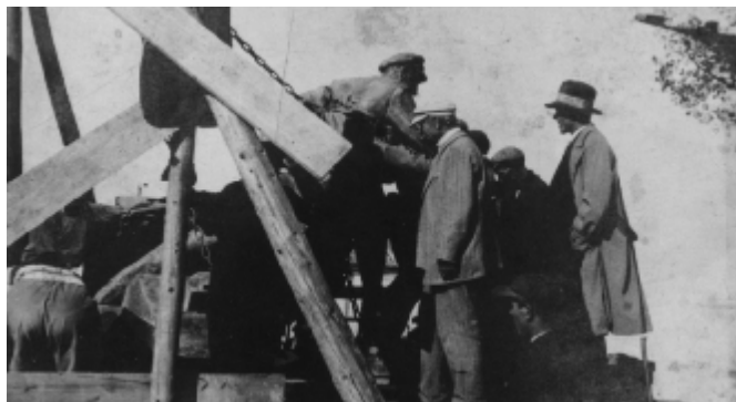
1932 r. Budowa pomnika plk. Leopolda Lisa-Kuli.
